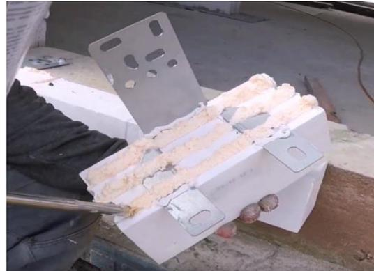
Foto Nr. 12 - Auftragen des PU-Klebers für Polystyrol
