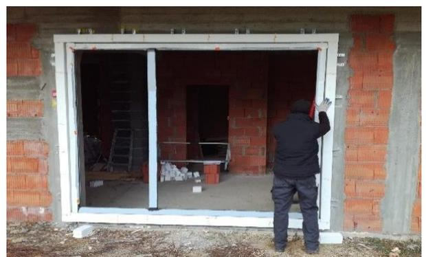
Foto Nr. 22 – Stabilisierung des Rahmens mit Keilen vor dem Bohren der Öffnungen und dem Einschrauben der Rahmenschrauben
