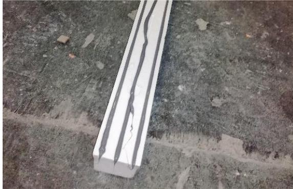
Foto Nr. 19 – Drei Reihen Hybridkleber auf dem BP-Balken. Verbindung des BP-Balkens mit CBM-Balken im
