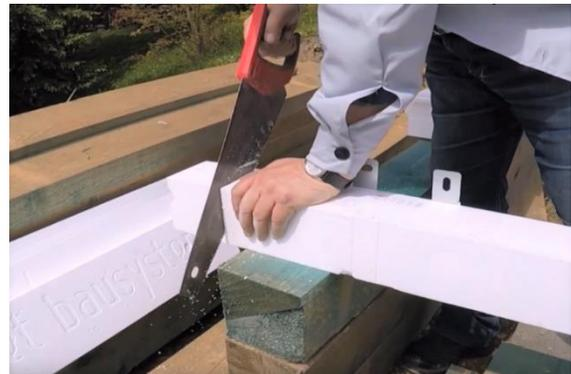
Foto Nr. 7 - Zuschneiden der CBM-Balken mit thermischer Saite Foto Nr. 8 - Zuschneiden der CBM-Balken mit Säge
