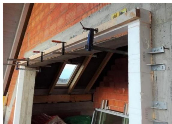
Foto Nr. 15 - Montage der oberen CBM-Linie Foto Nr. 16 – Der Einsatz der Zwingen erleichtert und beschleunigt die Arbeiten
