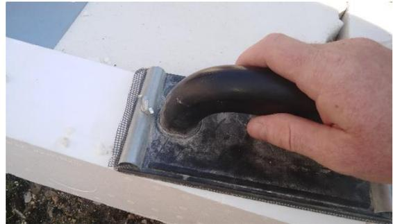
Foto Nr. 6 – Ausgleichen und Nivellieren der Styroporfläche unter die Schwellenbalken mit Hilfe des "Reibebretts für Styropor" oder der anderen schleifenden Werkzeuge
