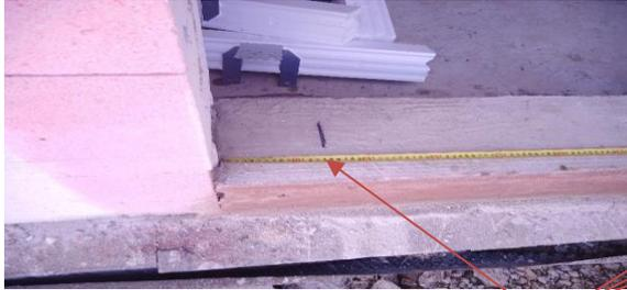
Foto Nr. 1 - Kontrollmessung der Öffnung, Auftragen der Achse von
