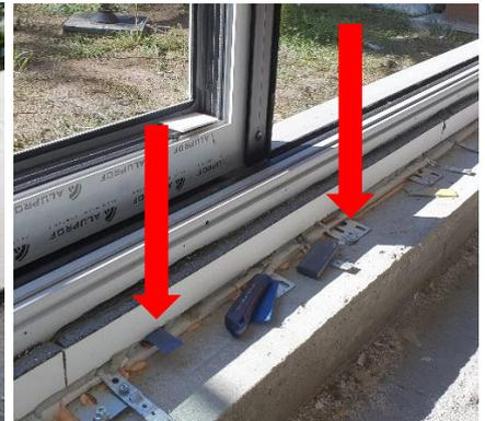
Foto Nr. 19 – Schleifen mit Hilfe eines Vibrationsschleifers oder eines Reibebretts Foto Nr. 20 – nicht empfohlene Verwendung von Plastikunterlagen
