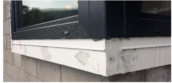
Foto Nr. 26 – Montagestelle des Unterbaus der äußeren Fensterbank (PPZ)
