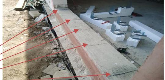
Foto Nr. 2 – geplante Anordnung der Montageachse
