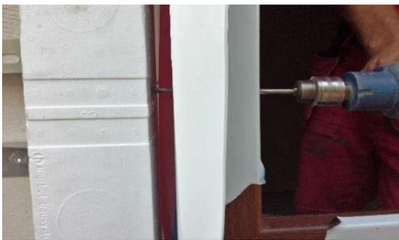
Foto Nr. 23 – Bohren der Öffnungen in den Konsolen
