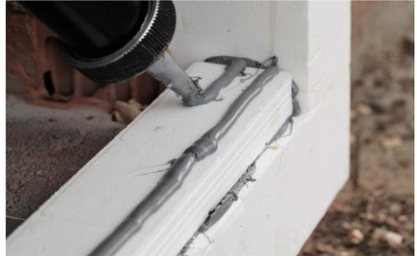
Foto Nr. 20– Auftragen des Hybridklebers auf den BP-Balken, Vorbereitung auf die Verbindung des BP-Balken mit dem Futterahmen
