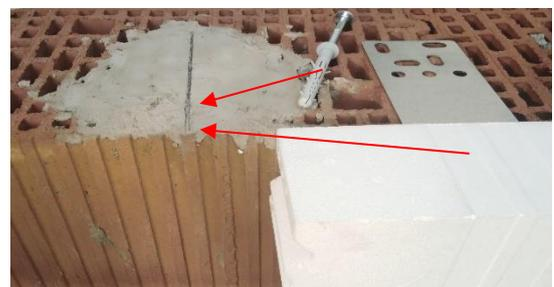
Foto Nr. 4 - Verstärkung der Untergrundtragfähigkeit an der Montagestelle der Bleche von CBM-Balken durch das Vergießen der keramischen Hohlsteine mit Mörtel
