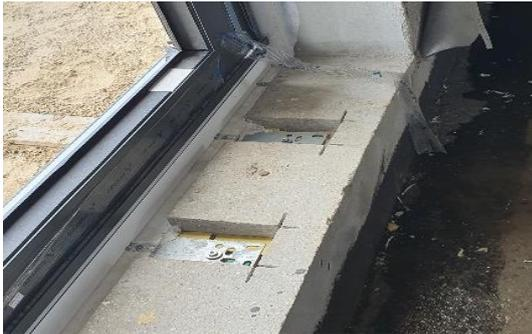
Foto Nr. 5 – Aufschneiden und Abbau der Stahlbetonschwelle. Setzen des Blechs der CBM-Konsole auf das erforderliche Niveau
